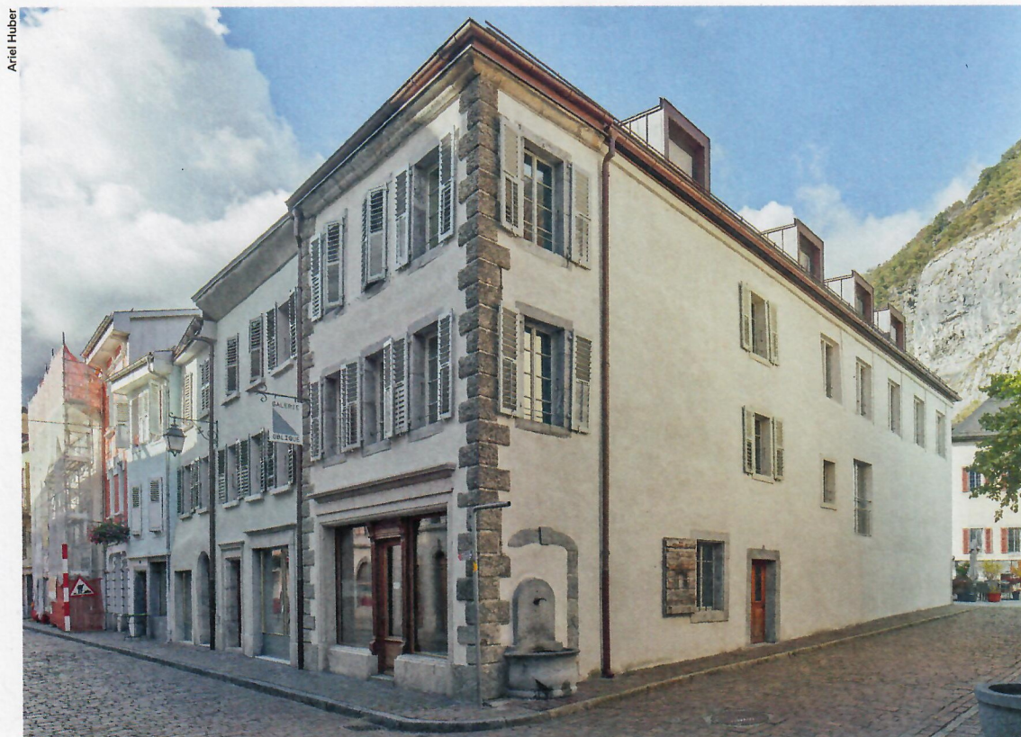
L'angle de la Grand-Rue et de la ruelle des Petites-Fontaines, où l'ancien et le neuf se rencontrent Die Ecke Grand-Rue und Ruelle des Petites-Fontaines, wo alt und neu aufeinandertreffen
