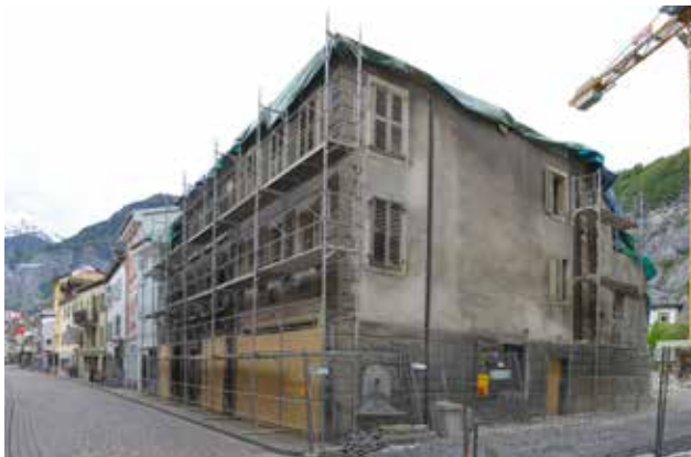
Le bâtiment au début des travaux... photo Clin d'oeil S. Rouiller
